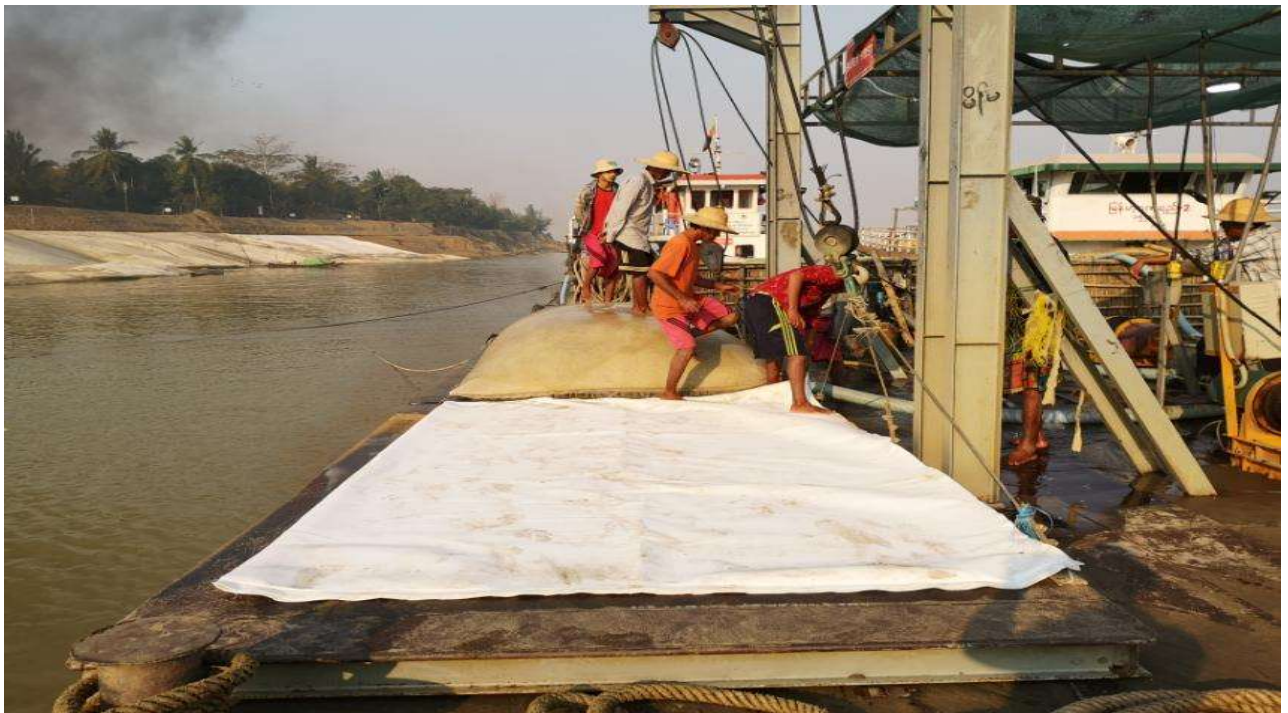
Geobags သဲထည့်ရန်ပြင်ဆင်နေသည့်အခြေအနေများ
