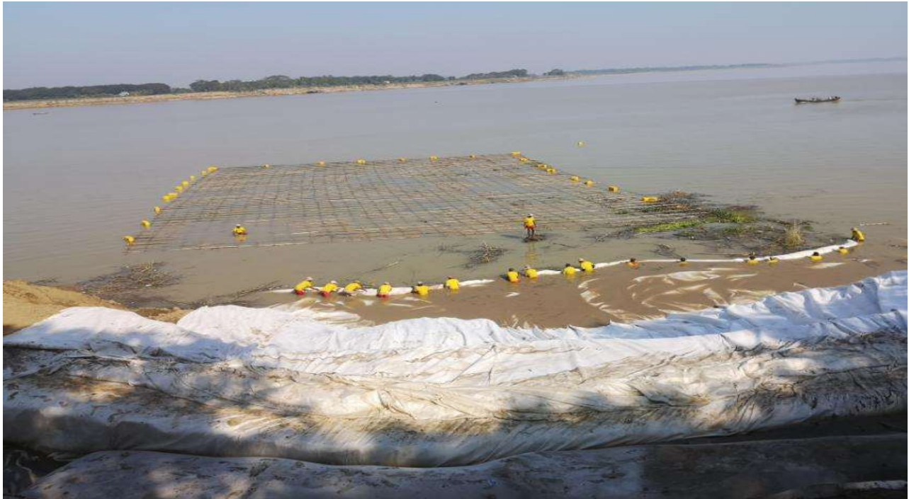
20 ton + 16 kn Geotextile အခင်း ခင်းခြင်းဆောင်ရွက်နေမှုပုံ
