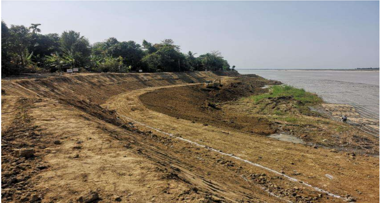
Top Side Slope ဆောင်ရွက်ပြီးမြေပြင်အနေအထား
