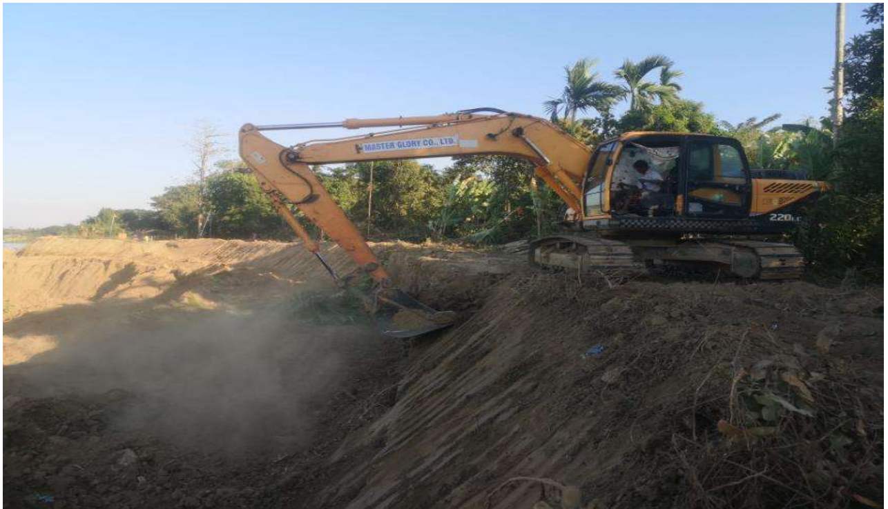
Hyundai 20 Ton Excavator ဖြင့် Top Side Slope ဆောင်ရွက်နေခြင်း
