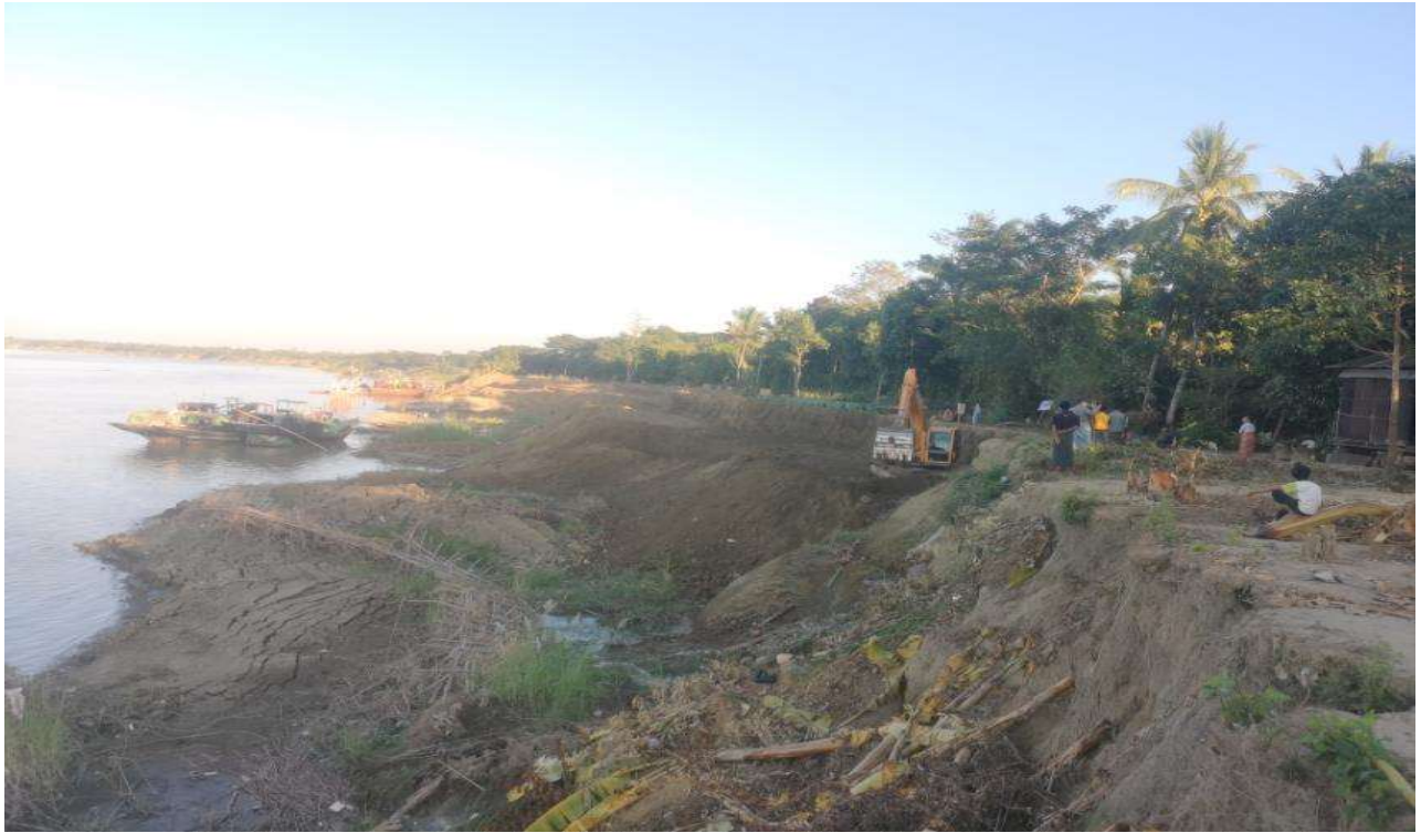
Hyundai 20 ton Excavator ဖြင့် မြေပြင်ရှင်းလင်းခြင်းဆောင်ရွက်နေပုံ
