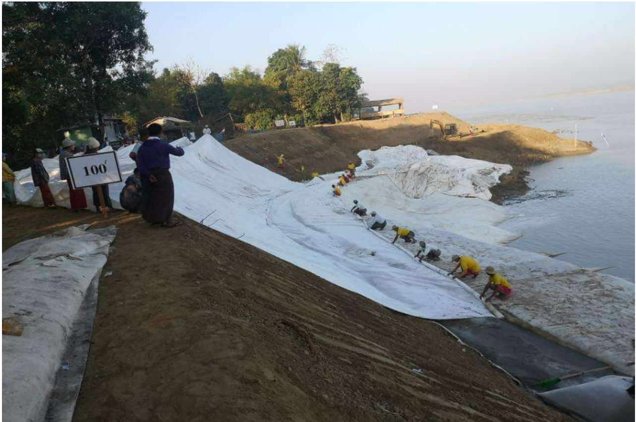
20 ton+ 16 kn Geotextile ခင်းရန်ပြင်ဆင်ခြင်း
