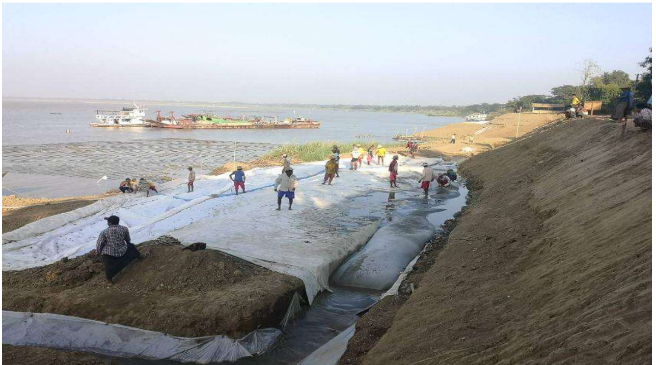
Key Trench Line အတွင် Geo Tube သဲမှုတ်ထည့်ခြင်း
