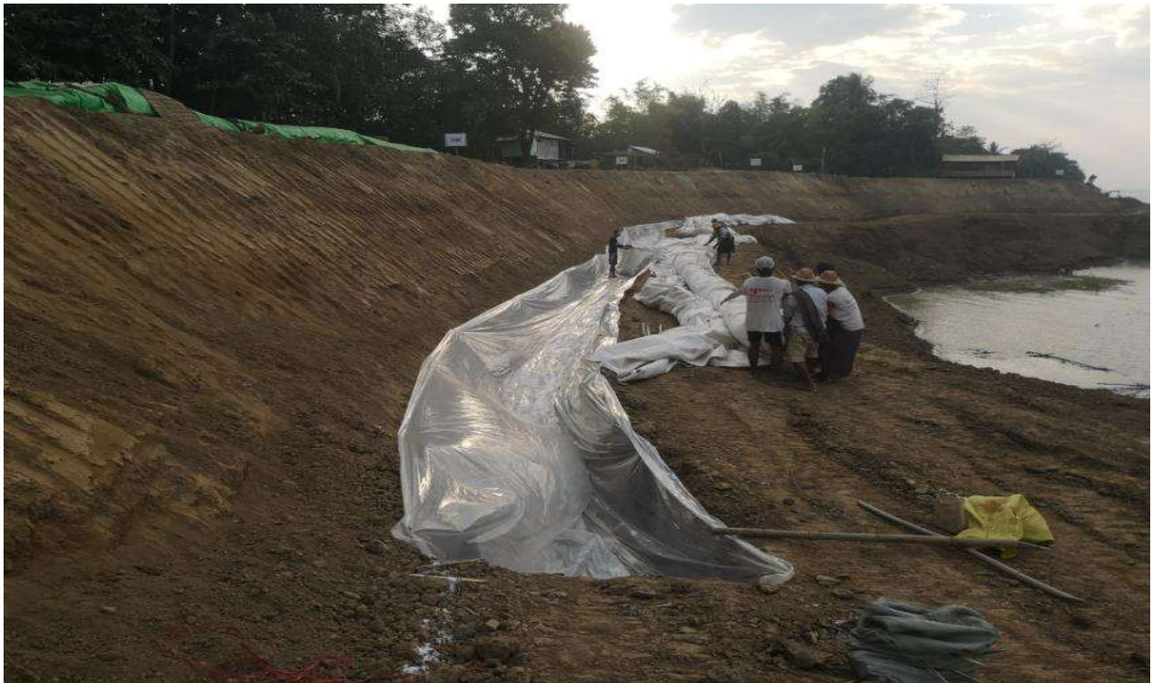
Geo Tube အတွင်းသို့သဲထည့်ရန်အတွက် ကြိုတင်ပြင်ဆင်မှုများ
