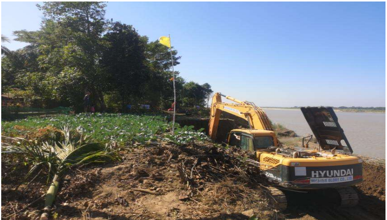
Hyundai 20 ton Excavator ဖြင့် မြေပြင်ရှင်းလင်းခြင်းဆောင်ရွက်နေပုံ
