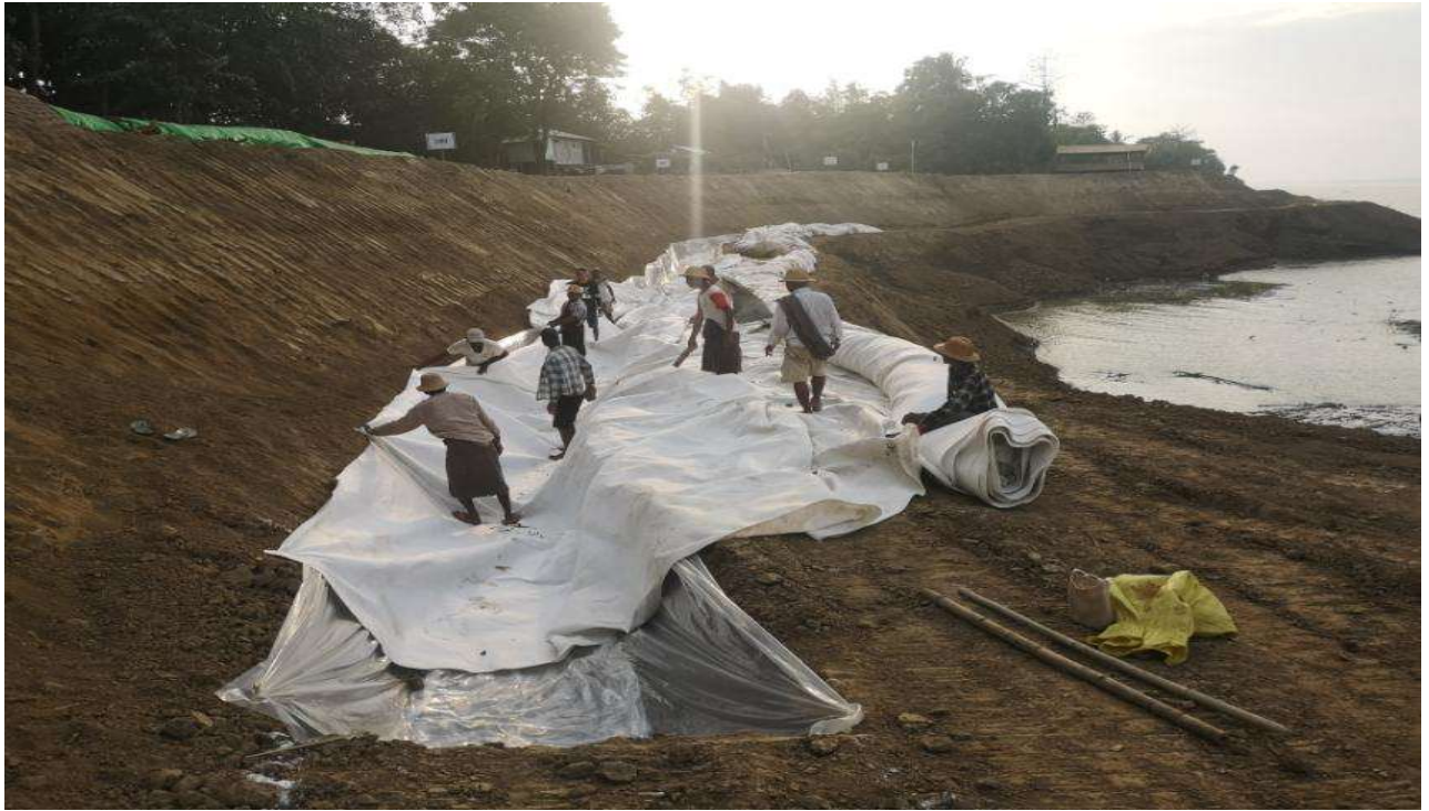
Geo Tube မမြုပ်ခင် 20 ton+16 kn Geotextile အောက်ခံခင်းခြင်း
