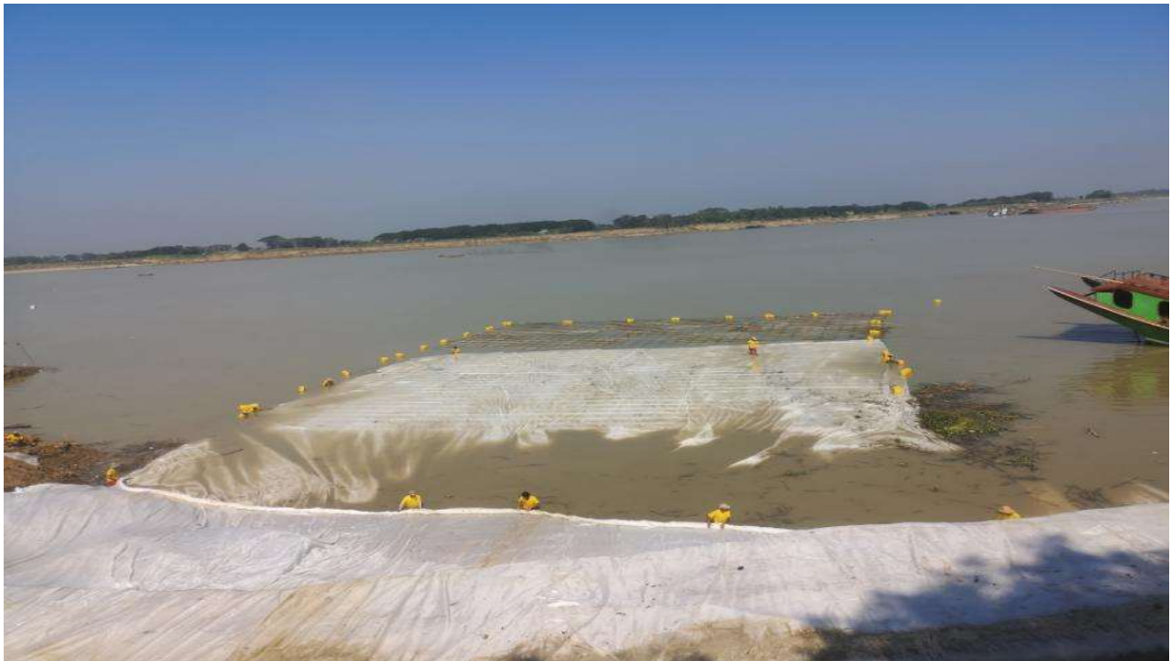
20 ton + 16 kn Geotextile အခင်း ခင်းခြင်းဆောင်ရွက်နေမှုပုံ
